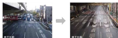
産業道路における踏切の除却
