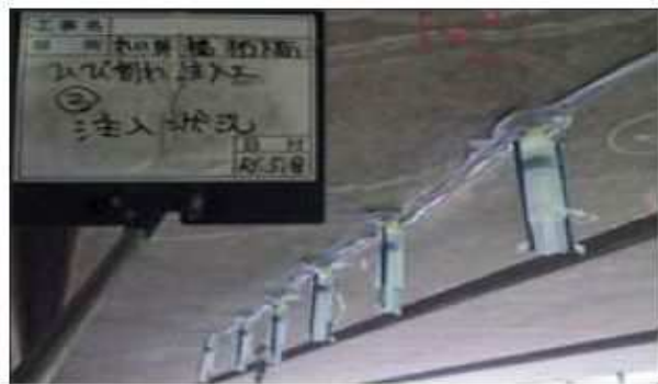
橋りょう桁下の予防保全的な修繕の例 (ひび割れに樹脂を注入) (出典:川崎市橋りょう長寿命化計画)
