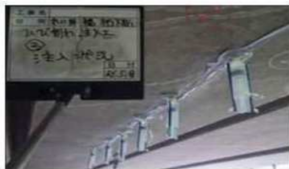
橋りょう桁下の予防保全的な修繕の例 (ひび割れに樹脂を注入) (出典)橋りょう長寿命化修繕計画 (令和3(2021)年2月)
