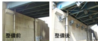
図 橋りょうの耐震化工事(小倉跨線橋)
