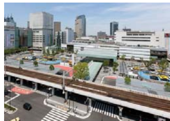
図 川崎駅東口駅前広場
