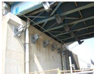
図 橋りょうの耐震化工事（再掲）（小倉跨線橋） （上：整備前、下：整備後） 出典：川崎市資料
