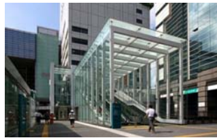
図 川崎駅東西連絡歩道橋のバリアフリー整備 出典：川崎市HP
