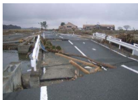
②落下した橋りょう 宮城県山元町相馬亘理線
