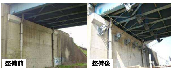
橋りょうの耐震化工事(小倉跨線橋)
