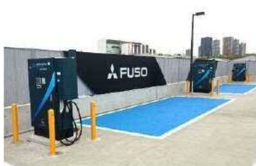
電気トラック用急速充電設備 (三菱ふそうトラック・バス(株)川崎工場内)
