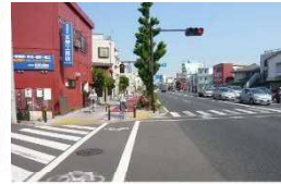
無電柱化された南幸町渡田線 【出典】川崎市資料
