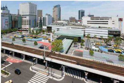
公共交通の利便性向上に向けた駅前広場の整備事例 (川崎駅東口駅前広場)
