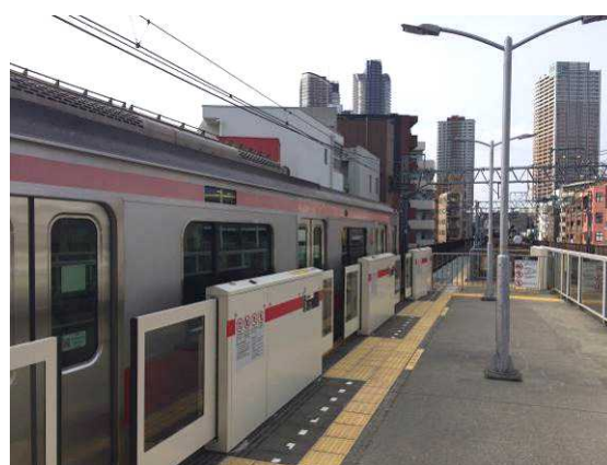
図 ホームドアの設置（東急東横線新丸子駅） 出典：川崎市資料
