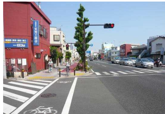
図 無電柱化された道路 (南幸町渡田線)
