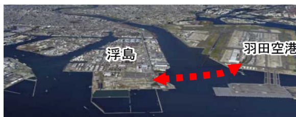
図 国道357号 多摩川トンネル区間
