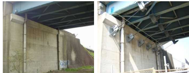
図 橋りょうの耐震化工事（再掲）（小倉跨線橋） 左：整備前、右：整備後
