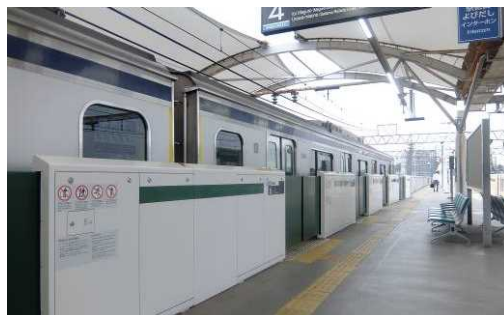
図 ホームドアの設置（東急目黒線元住吉駅）
