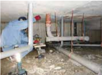
1階床下ピットの 配管調査
