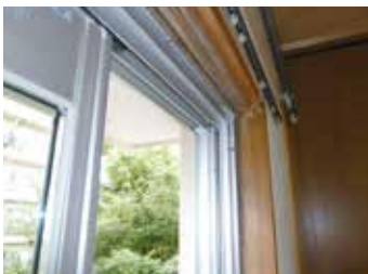
既存枠に新たな枠を設置
