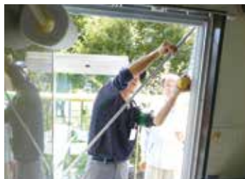
カバー工法にて施工
