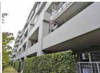
バルコニー側の外付けフレーム 設置完了後
