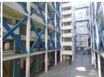
中庭側に新設した鉄骨ブレース
