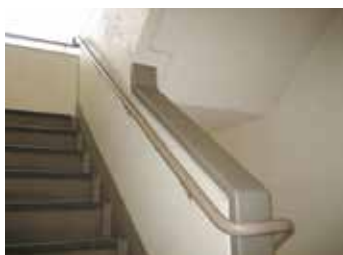
共用階段の手すり
