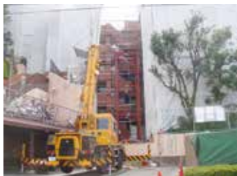
受水槽を撤去した跡地に エレベーターを設置する
