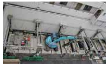
重機を使って機械式駐車場を解体
