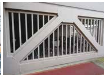
鉄骨ブレース設置、塗装完了後
