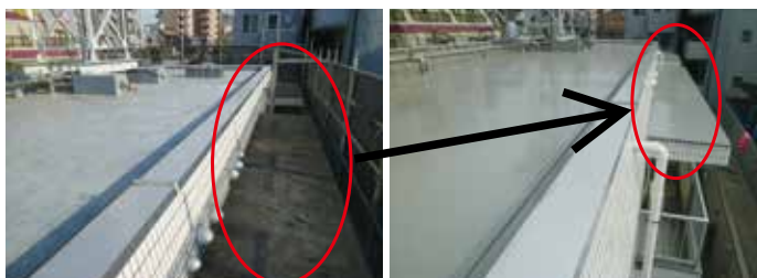
屋上や底部分の工事前
