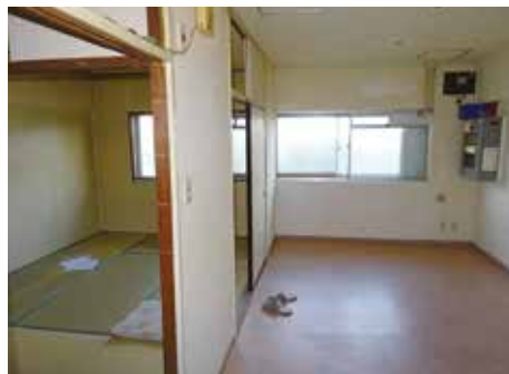
管理員の居室はコミュニティ スペースに改装予定
