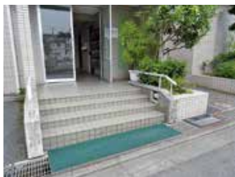
車いすでは上がれない エントランス
