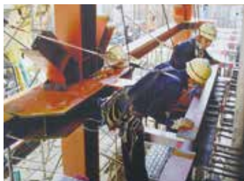
鉄骨ブレースを開放廊下に 接続する作業
