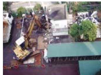
受水槽、ポンプ室を解体中
