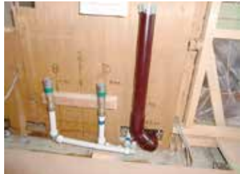
台所の新規配管 立ち上がり部分
