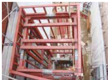
新設エレベーターの鉄骨組みを 上から見たところ
