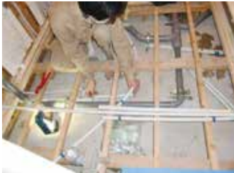
洗面所給排水管設置 作業中
