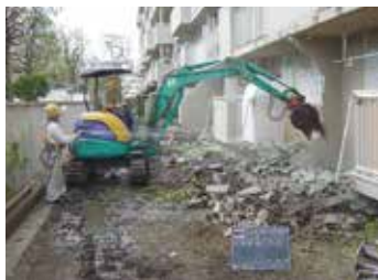
外付けフレーム設置に際し、 既存のバルコニーを解体
