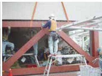
ピロティ部分に 鉄骨ブレースの設置
