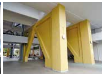
鉄筋コンクリート造の 耐震補強壁を新設
