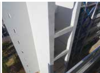
建物の偏心を抑える耐震壁を増設
