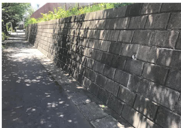
間知ブロック擁壁の設置例 （助成金の対象外です）
