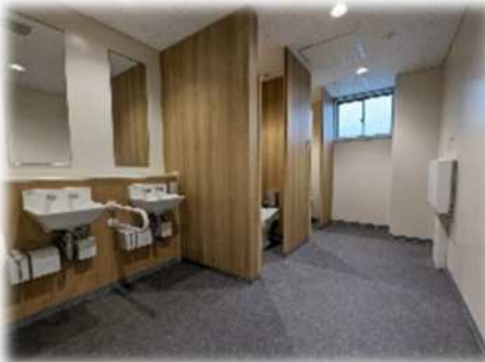
トイレ、給湯室の改修
