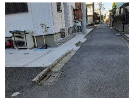
二項道路（左手前は後退済みでL字型側溝は前の位置のまま）
