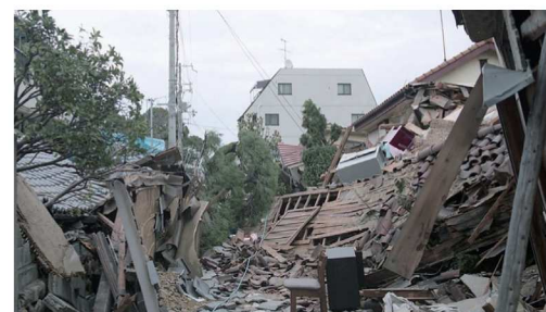
兵庫県南部地震時の建物倒壊・道路閉塞の様子(出典:神戸市)
