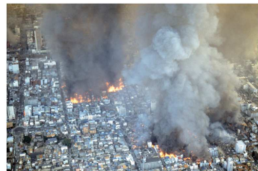
兵庫県南部地震時の広範囲な火災延焼の様子(出典:神戸市)
