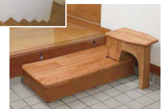
左／階段への 手すりの設置 下／段差の縮小
