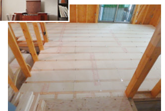
左／内窓の設置 下／床下の断熱改修
