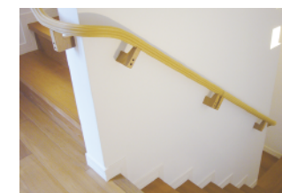
左／階段への 手すりの設置 下／段差の縮小
