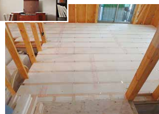
左／内窓の設置 下／床下の断熱改修
