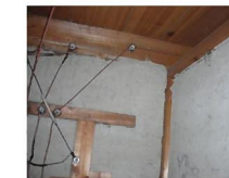
壁上端まで施工 外側
