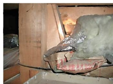
断熱材をめくって 確認する。確認後、 断熱材を元に戻す。
