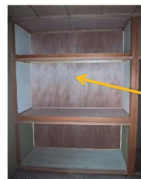
耐震壁仕様で施工された構造用合板壁(補強時)
