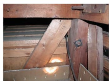
筋かい端部金物なし (釘打ち)
