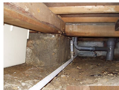
浴室床下 漏水による腐朽 基礎立ち上がりが湿っている
