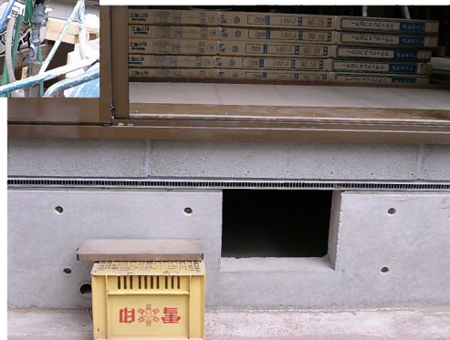
床下換気口新設
