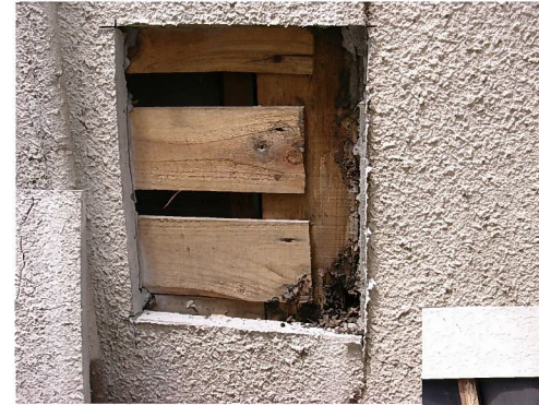
外壁：モルタル壁
