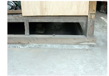
廊下下の基礎
