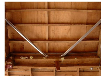
火打ちの増設
