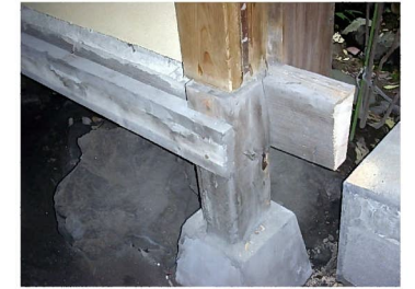
廊下下の基礎
