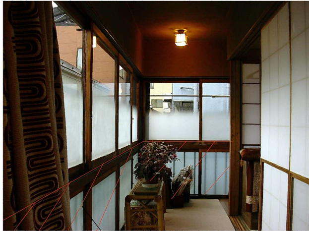
斜線範囲腰壁増設
