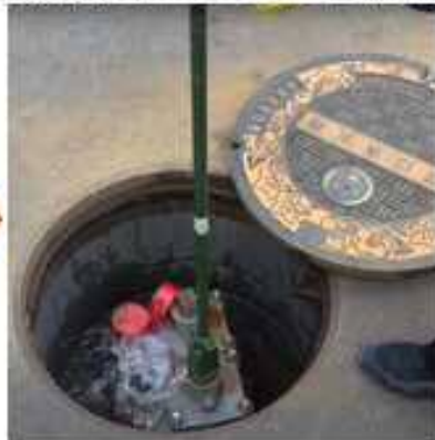
② 開閉器でバルブを少し開ける
