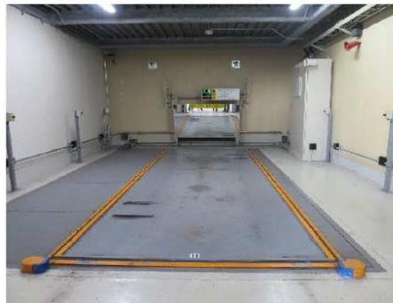
図4 車椅子使用者が円滑に乗降可能な機械式駐車場の例
