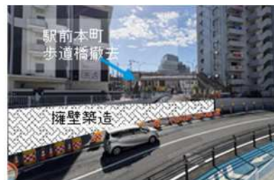
▲歩道橋撤去・擁壁工事_イメージ
