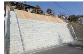
助成制度を活用した擁壁の改修事例
