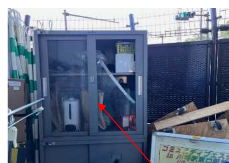
分電盤、上下水道の鍵の保管場所
