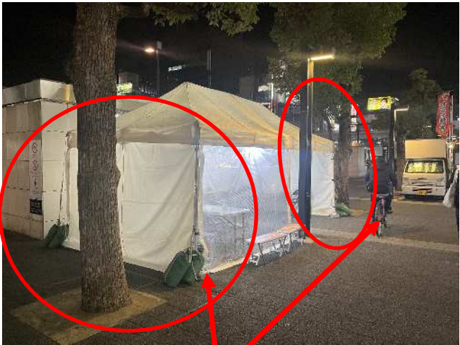
(参考) テント上部のロープによる固定
