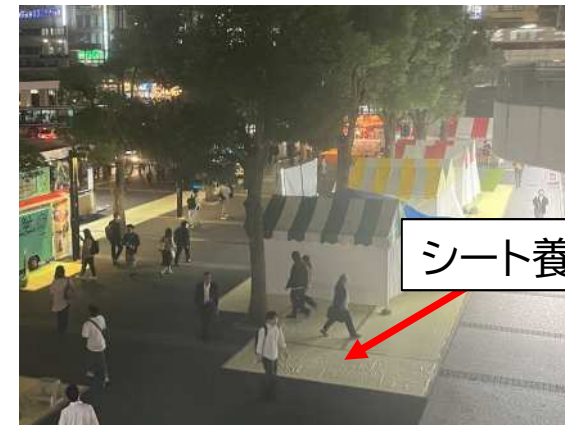
汚損防止シート養生
