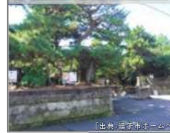
大正時代から残る建物と石垣、並木など、逗子のまちなみを感じる景観を残した事例
