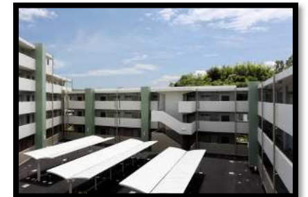
↑市営真福寺住宅の建替え （公営住宅等整備事業）
