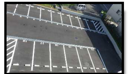
↑市営真福寺住宅の駐車場整備 （公営住宅駐車場整備事業）
