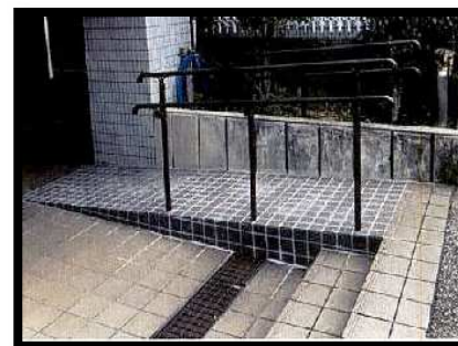
↑手すり・スロープ設置工事 （住まいバリアフリー化推進事業）
