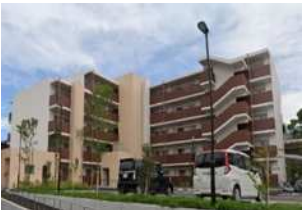
生田住宅1号棟
