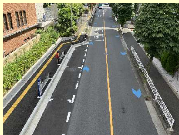
ラバーポール撤去後
