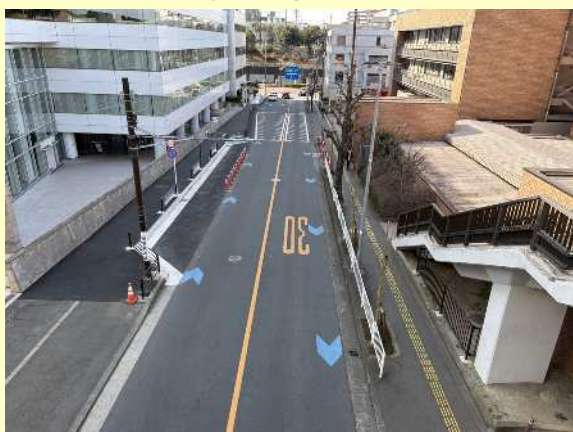
ラバーポール撤去前
