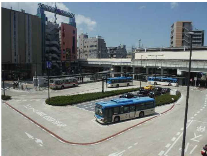
武蔵溝ノ口駅南口駅前広場(高津区)
