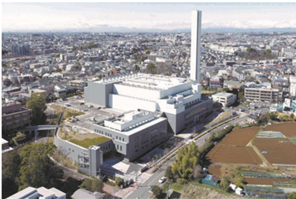
橘処理センター（高津区）
