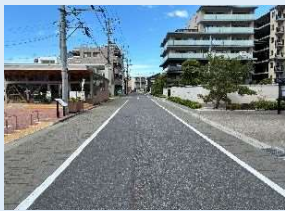
8m区域道路整備
