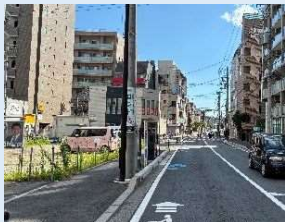
電線共同溝区間
