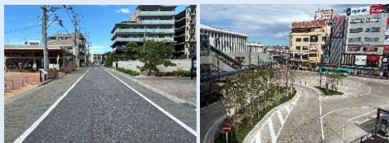
8m区域道路整備
