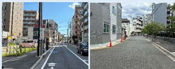
電線共同溝区間
