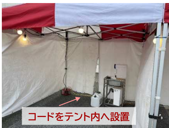
(参考)テント内等への コード設置
