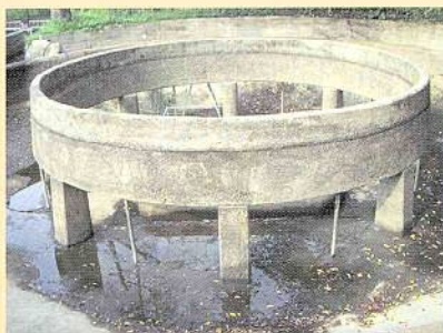
水を抜いた円筒分水
