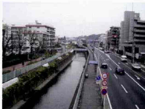
二ヶ領本川稲生橋下流
