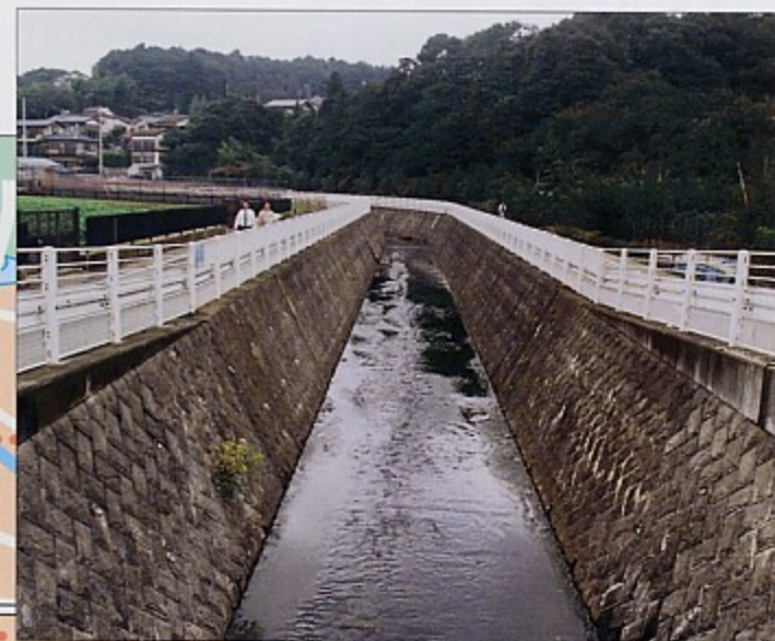
●平瀬川支川 (宮前区菅生1丁目地内)
