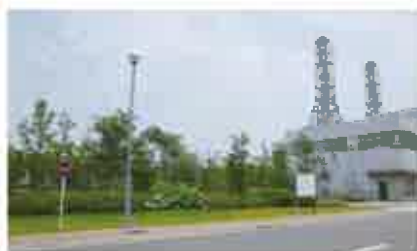
③⑥ 川崎天然ガス発電株式会社 川崎天然ガス発電所
