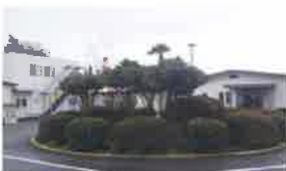
⑫セントラル硝子株式会社川崎工場
