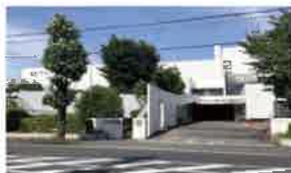
④⑥ 株式会社朝日プリンテック川崎工場
