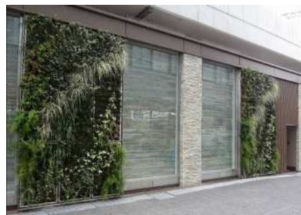
壁面緑化（川崎区）
