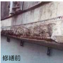
生田根岸跨線橋（多摩区）【断面修復】
