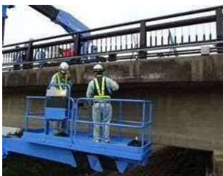
橋梁点検車を使った点検（鷹野大橋）
