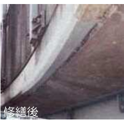
生田根岸跨線橋（多摩区）【断面修復】
