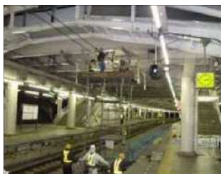
鉄道委託による点検（梶ヶ谷跨線橋）
