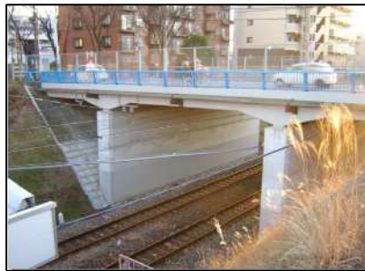
花園橋（跨線橋） 宮前区
