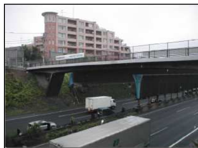
宮下橋（跨道橋） 宮前区
