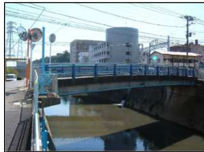
中吉橋（橋梁15m以上） 中原区
