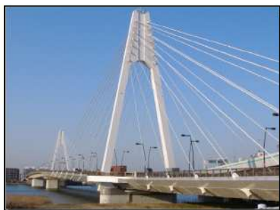
大師橋（緊急輸送道路） 川崎区
