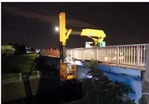
写真2-1 従来工法による点検状況の例
