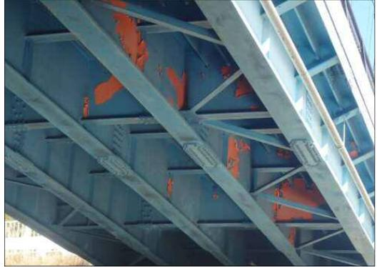
写真6-5 鋼桁の防食機能の劣化
