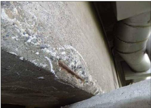
写真6-6 コンクリート桁の剥離・鉄筋露出
