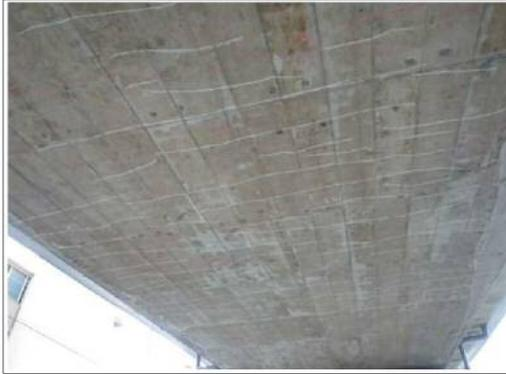
写真6-4 コンクリート床版橋（中空床版橋）
