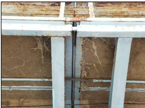
写真6-8 コンクリート床版のひび割れ
