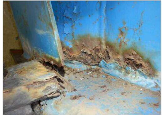
写真6-7 鋼桁の亀裂・腐食
