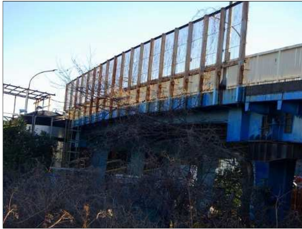
写真9-1 扇町跨線橋（跨線部全景）
