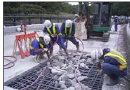
出典：国土交通省資料 写真6-2 大規模な補修の例 (コンクリート床版を打ち換え)
