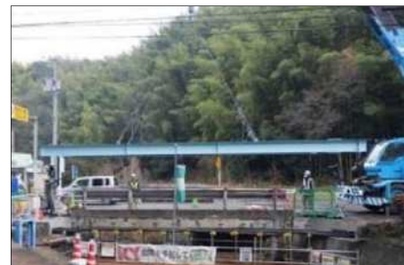
出典：国土交通省資料 写真6-3 橋りょうの架替の例
