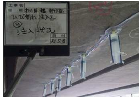
写真6-1 予防保全な修繕の例 (ひび割れに樹脂を注入)
