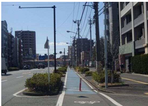
市道富士見鶴見駅線 (自転車道)
