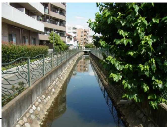
写真 9 久地円筒分水～渋川分岐までの様子
