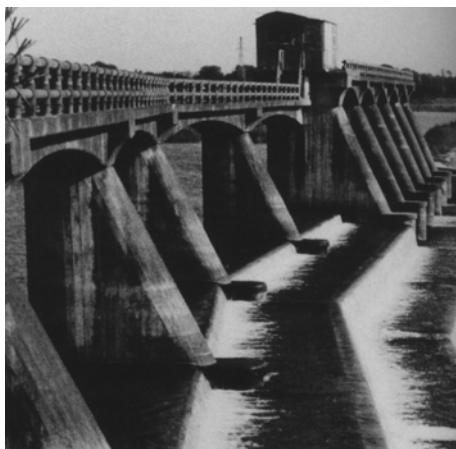
(昭和 20 (1945) 年竣工の上河原堰)
