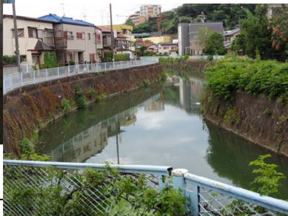
写真 8 台和橋～久地円筒分水までの様子
