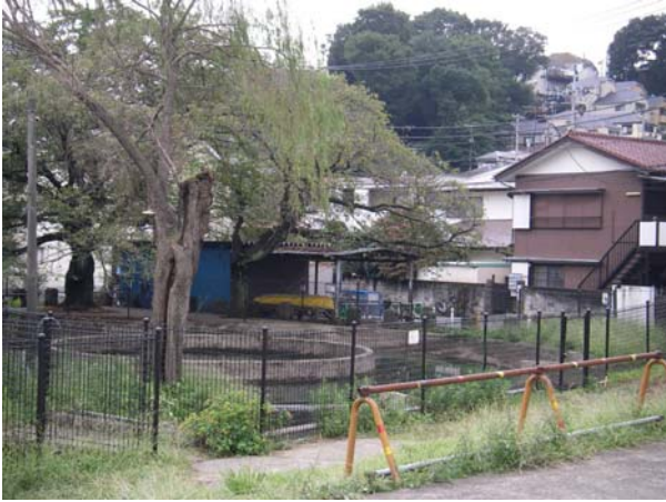
修景整備前（平成 18(2006)年 10 月）
