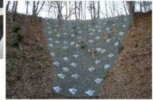
最小限の伐採で斜面安定が図れるため、 緑地保全に有効な工法の一つである。
