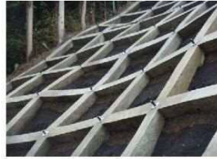
↑従来の工法例 (法枠工+ロックボルト)
