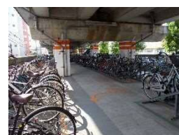
駐輪場（中原区）
