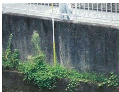
図 6.3 護岸の目地ぎれの補修
