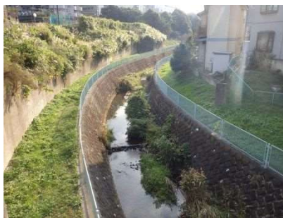
図 14.20 麻生川(麻生区)
