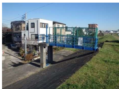
図 14.21 久地排水樋管(高津区)
