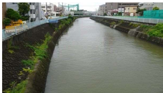
図 5.2 出水時の河川状況(平瀬川)
