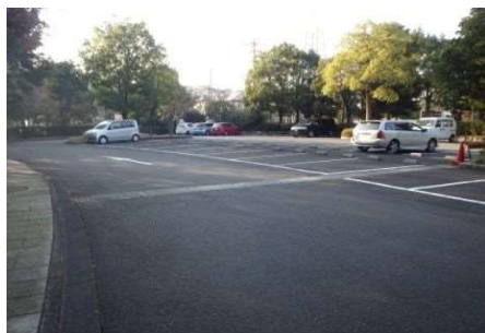
図 14.10 王禅寺ふるさと公園駐車場地下貯留施設の上部(麻生区)
