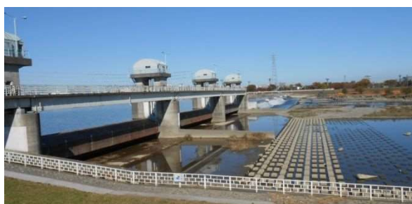
図 3.8 上河原堰堤(供用約 50 年)
