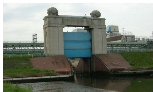
図 3.9 川崎河港水門(供用約 90 年)
