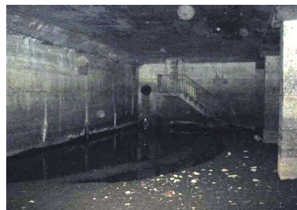
図 14.11 王禅寺ふるさと公園駐車場地下貯留施設の内部(麻生区)
