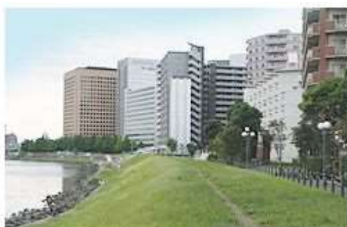
図 14.33 戸手地区の一部完成区域（幸区）
