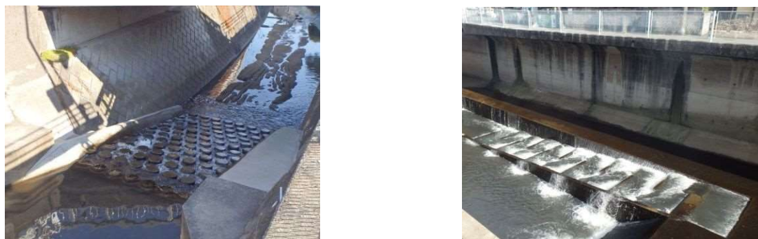
図 6.9 魚道(左:平瀬川支川 右:平瀬川)
