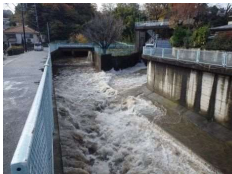
図 5.7 出水状況 (二ヶ領本川と平瀬川の合流部)
