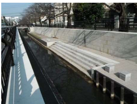
図 6.11 渋川環境整備工事における階段工
