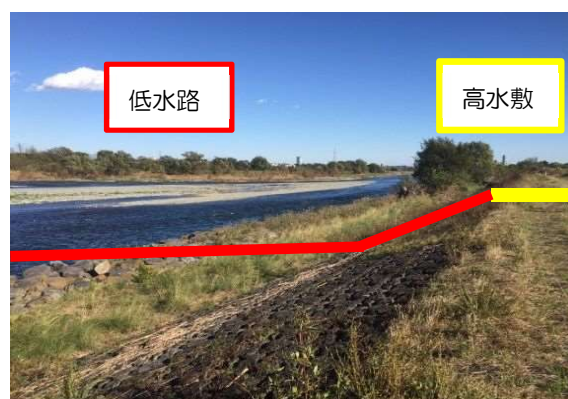
図 14.17 多摩川の高水敷と低水路
