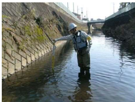
図 5.4 詳細点検実施状況(平瀬川)
