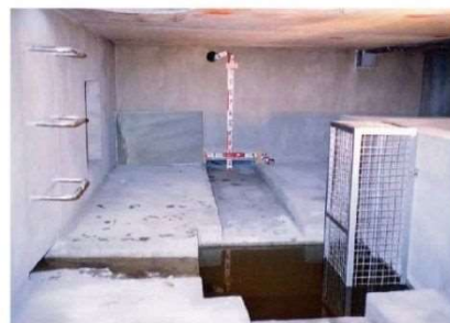
図 14.13 地下貯留槽内部
