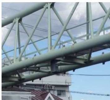
図 14.31 平瀬川下流テレメータ水位計(高津区)
