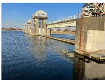
図 4.2 堰堤による利水の例
