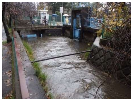
図 5.8 出水状況 (二ヶ領用水と洪川の分流部)
