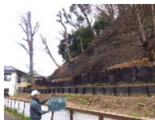
橋特別緑地保全地区に設置した土砂止め防護柵
