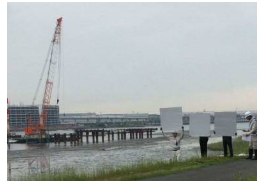
色見本版による現地確認状況
