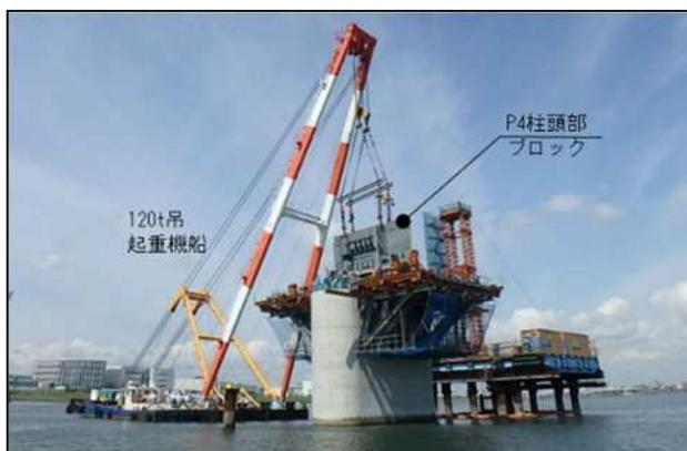
柱頭部 鋼桁据付
