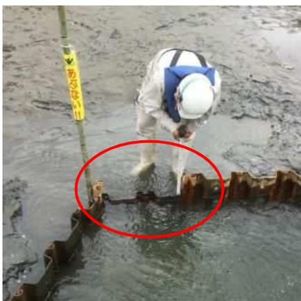
図 2.2.16 矢板打ち下げ状況(帯水対策)
