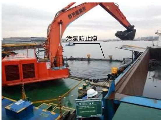
図 2.2.20 汚濁防止膜設置状況
