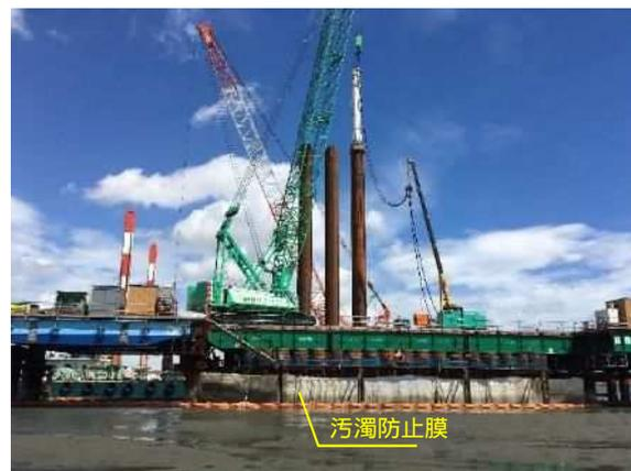
図 2.2.21 汚濁防止膜設置状況
